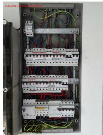
Dispositifs à courant différentiel installés: 4P 40 A 300 mA type A, circuit(s) protégé(s): Voir schémas
